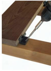
3. Die Schraube im Winkel von ca. 65° ansetzen und sie bis zu einem Fugenbild von 6mm eindrehen.
