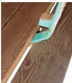
1. Zum Auswechseln einer Diele benötigen Sie lediglich ein einfaches Hebelwerkzeug. Das Hebelwerkzeug ansetzen und die Diele herausnehmen.
