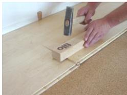
(7) **Klopfen Sie** nach dem Absenken **mäßig von oben auf die stirnseitige Verbindung** (Schlagklotz beilegen, um Beschädigung zu vermeiden). Dabei rastet die Verbindung ein. Für einen optimalen Fugenschluss der stirnseitigen Verbindung klopfen Sie nach dem Einrasten noch mal auf das freie Stirnende (8). Bei der letzten Diele verwenden Sie ein Zugeisen. (9)
