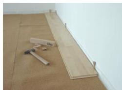
**Erste Reihe:**(1) Legen Sie die erste Diele in die linke Raumecke **mit der Federseite zur Wand**. Arbeiten Sie von links nach rechts. Abstandskeile für Dehnfuge zur Wand (ca. 1 cm) längs- und stirnseitig verwenden.
