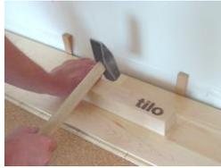
(3) **Klopfen Sie mäßig von oben auf die stirnseitige Verbindung** (Schlagklotz beilegen, um Beschädigung zu vermeiden). Dabei rastet die Verbindung ein. So verfahren Sie bis zur letzten Diele der Reihe.
