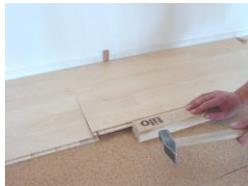
(6) Die zweite Diele der zweiten Reihe wird ebenso mit der Feder in die längsseitige Nut der bereits verlegten Diele lose eingelegt. Die Stirnseite muss **dicht an das verlegte Stirnende** gestoßen werden. Durch Klopfen wird die Diele abgesenkt. Kontrollieren Sie beim Absenken, ob die Stirnfuge noch dicht ist. Falls notwendig, zwischendurch auf das freie Stirnende klopfen.
