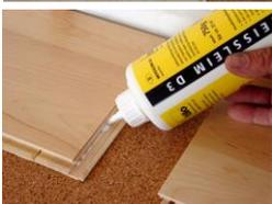
**Sägen** Sie die letzte Dielenreihe längs **auf passende Breite**. Halten Sie eine **Dehnfuge von ca. 1 cm** Breite zur Wand ein! Wenn die Diele nicht von oben eingewinkelt werden kann (bei niedrigen Heizkörpern, an Türverkleidungen usw.), schneiden Sie die Nase der unteren Nutwange weg, tragen Sie etwas wasserfesten tilo D3-Weißleim auf und setzen Sie die Diele ein.
