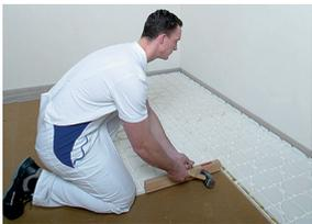
Die Elemente werden stirnseitig mittels Hammer und NORIT-Haudegen zusammengefügt. Direktes Schlagen mit dem Hammer auf das Klick-Profil kann zu Beschädigungen führen. Dehnungsfugen sind erst ab einer Raumlänge von 20 m vorzusehen.
