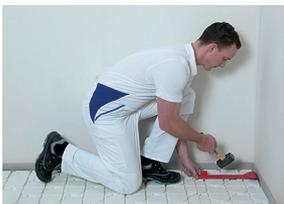
Die Randplatten können mit Hilfe eines TE-Zugeisens leicht eingesetzt werden. Nach Abschluss der Arbeiten müssen evtl. gesetzte Keile entfernt werden. Zur Vorbereitung auf die folgenden Arbeitsschritte muss die Fläche staubfrei und frei von Verschmutzungen sein.
