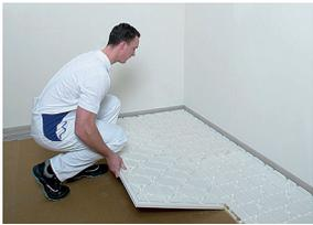
Die TE Therm-Elemente werden schräg angesetzt und mit leichtem Druck gegen die bereits verlegte Platte abgelegt. Bei der weiteren Verlegung ist auf eine geschlossene Längsfuge zu achten. (siehe: Plattenverlegung falsch/richtig)
