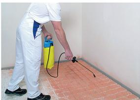
Die rötliche Grundierung wird mit einem Druckprüher gleichmäßig aufgebracht. Um auch die Flanken der Ausfräsungen vollständig zu grundieren, wird das kreuzweise Sprühen aus mehreren Richtungen empfohlen. Die NORIT-Grundierung
