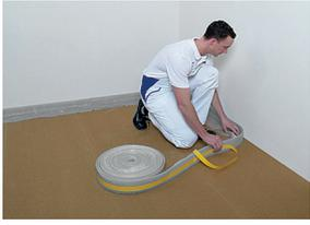
Vor der Verlegung der TE Therm-Elemente wird umlaufend der NORIT-Randdämmstreifen angebracht. Die befestigte Folie wird voll ausgebreitet in den Raum gelegt. In Ecken wird die Folie überlappt. An Kanten wird eine zusätzliche Folie zur Abdichtung angebracht. Das Abkleben von Stößen des Randdämmstreifens und der Schleppfolie ermöglicht ein sicheres Vergießen der Fläche.
