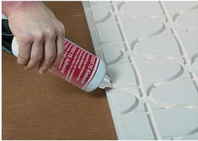
Die Verbindungsflächen müssen trocken, staub- und fettfrei sein. Der NORIT-TE-Klebstoff wird auf die Anlegezone des schon verlegten Elements aufgebracht. Dabei kann die Flasche an der oberen Plattenkante entlang geführt werden, so dass der Klebstoff (Verbrauchsmenge ca. 18 g/m<sup>2</sup>) hinter der Rille aufgetragen wird.
