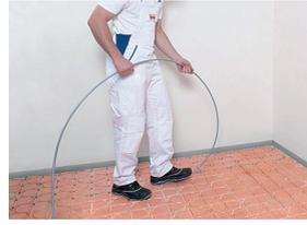
Das NORIT-Heizrohr wird nach der Vorgabe des Fachplaners verlegt. Es ist darauf zu achten, dass das Rohr sauber in die fix-Führung einklickt, es darf nicht verdrillen oder knicken. Die max. Heizkreislänge von 80 m kann durch die laufende Markierung auf dem Rohr kontrolliert werden. Wird das Heizrohr durch aufsteigende Bauteile oder Zwischendecken verlegt, muss dies durch ein geeignetes Schutzrohr geführt werden.
