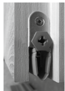
MODELL: ABSENKBARE BODENDICHTUNG
