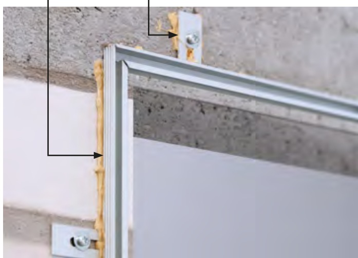
1. Putzprofil mit Befestigungslaschen auf der Wand montiert
