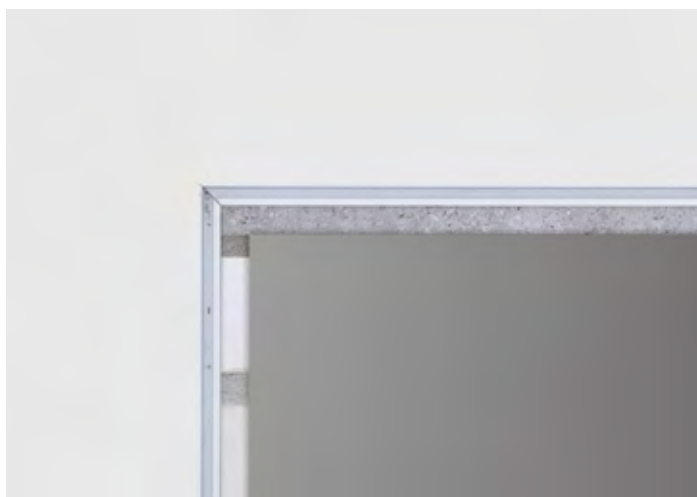
3. Fertiggestellte Wandoberfläche mit überdecktem Putzprofil
