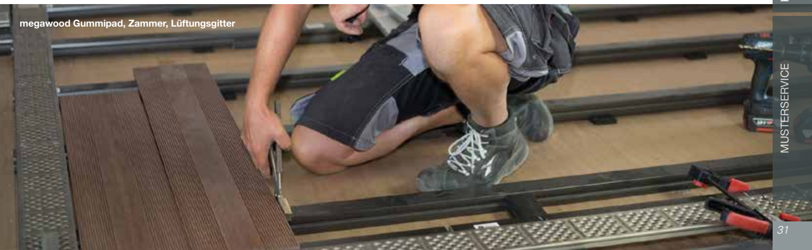
Distanzstück 5 mm / 8 mm Fuge
