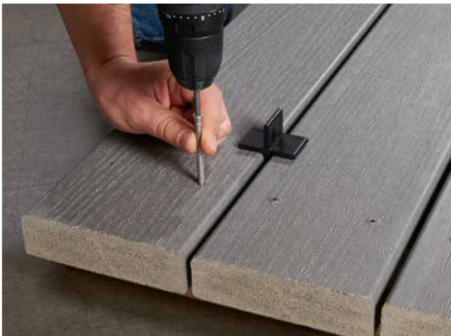
Verschraubung der Tragbohle
