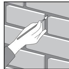
**6.** Sobald alles abgedichtet ist, beseitigen wir mit Hilfe eines feinen Pinsels mögliche Unebenheiten in Fugen und Löchern. Sobald die Dichtungsmasse absolut trocken ist (ca. 24 Std.), streichen wir Fugen und/oder Löcher mit Panespol-Fugenfarbe, um so ein tadelloses Endergebnis zu erzielen.
