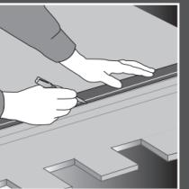
**B.** Partendo da questa linea tracciarne una parallela ad una distanza doppia rispetto allo spessore del pannello (da 2 a 4 cm, in base al modello).
